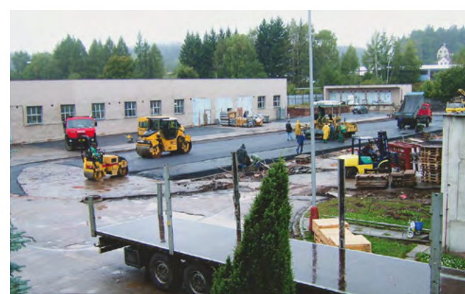
KKT – 2003 – při přestavbě nádvoří – asfaltování
