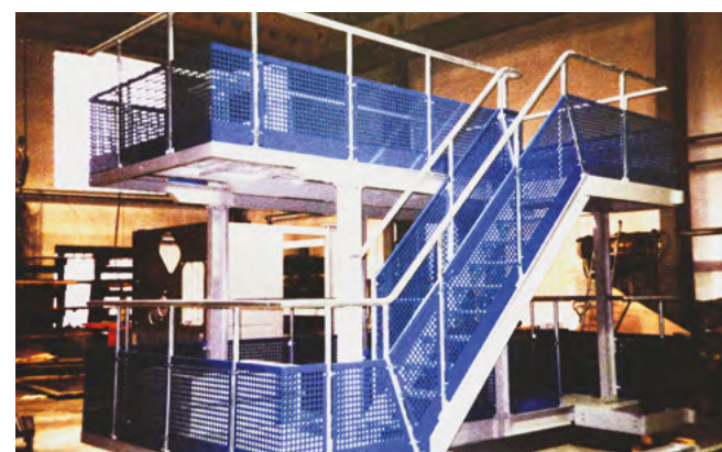
KKÚ – 1999 – obslužné schodiště
